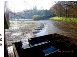
vue du plan d'eau depuis l'aval pendant la vidange
